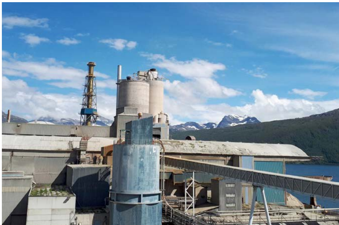
Svovelrenseanlegg ved Norcem Kjøpsvik. Foto: Norcem
