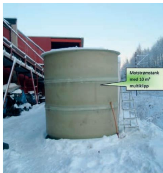
Figur 31. Skisse av motstrømsanlegg og bilde av anlegget på Oppland Metall. Mediet er multiklipp brukt som rensemedium (Østeraas, 2014)
