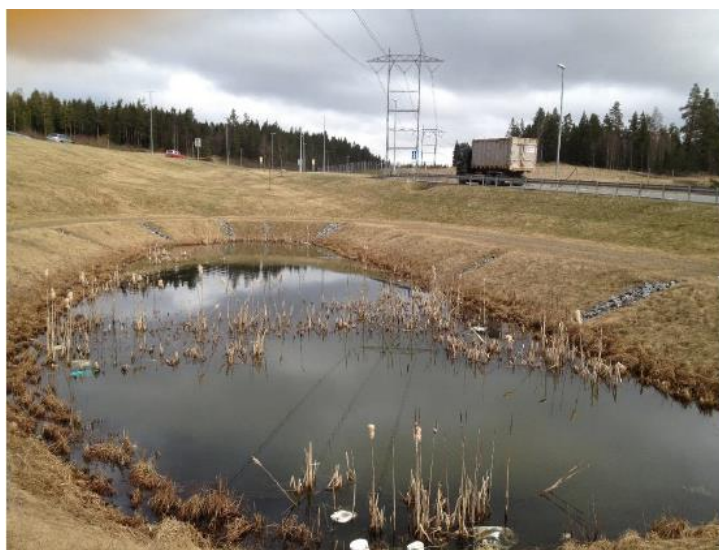
Figur 27. Eksempel på sedimenterings dam bygget for å rense overvann fra vei ved E18, Fossbekken (Foto: Meland) (CEDR. 2016).
