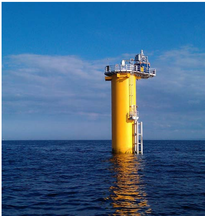
Fundament - Sheringham Shoal. Foto: E. Bjerknes
