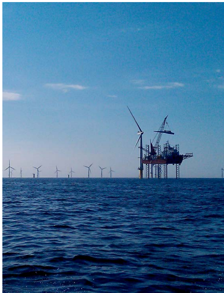
Installasjon av blader – fra prosjektet Sheringham Shoal. Foto: E.Bjerknes
