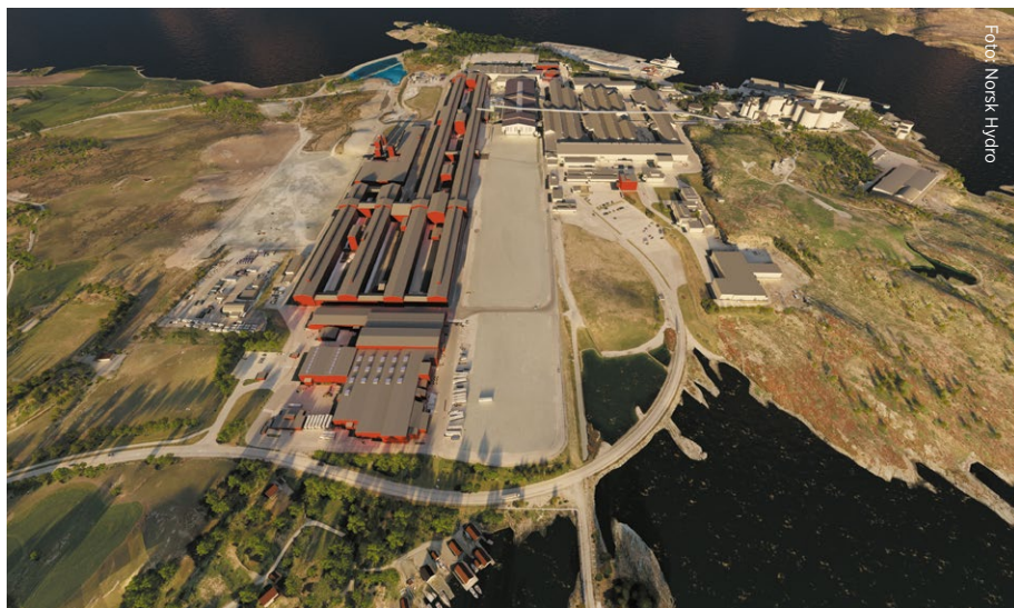
Hydros pilotanlegg står klart til drift i 2017 med verdens mest klima- og energieffektive produksjonsteknologi for aluminium.
