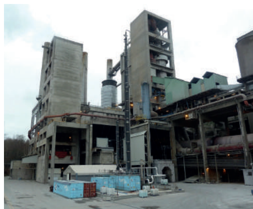
Aker Solutions Mobile Test Unit (MTU) på Norcems sementfabrikk i Brevik (Foto: Aker Solutions)
