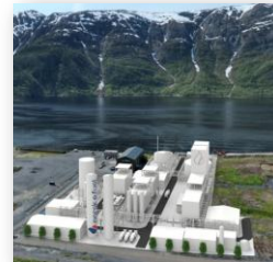
Foto: Norsk e-fuel/ Gen2 energy, Mosjøen. E-fuel produksjon basert på fanget CO2 og produsert H2
