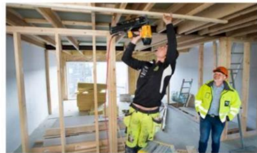
Tømmer Gunnar Steinland er i full gang med arbeidene på nye boliger i Serbøhagene i Sandnes. Til høyre er konsernsjef i Østerhus-gruppen, Njål Østerhus.
