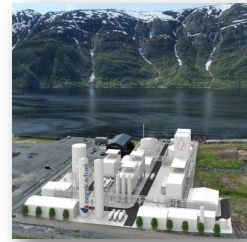
Foto: Norsk e-fuel/ Gen2 energy, Mosjøen. E-fuel produksjon basert på fanget CO2 og produsert H2
